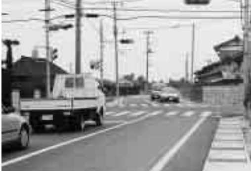
道路拡幅改良がされた村道1-12号線(宮ノ台地先)
