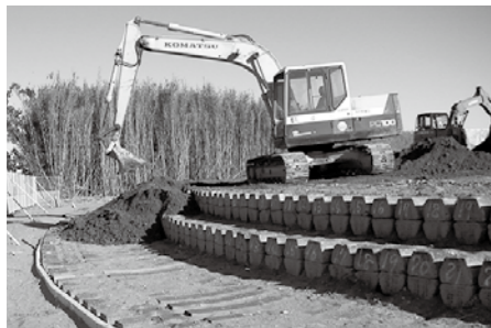
【築山公園建設状況 (H27.2.10)】 津波の引き波による被害を防ぐため、築山公園城之内・竜宮台地先ともに陸側の法面に強固なコンクリート枕木が土台部分に施工されています。
