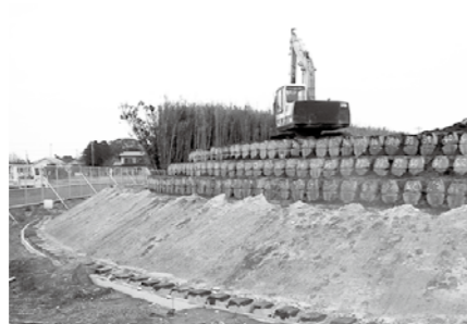
【築山公園建設状況 (H27.2.24)】 5メートルまでの盛土高さまで、陸側の法面に強固なコンクリート枕木とふとんカゴにより施工されています。
