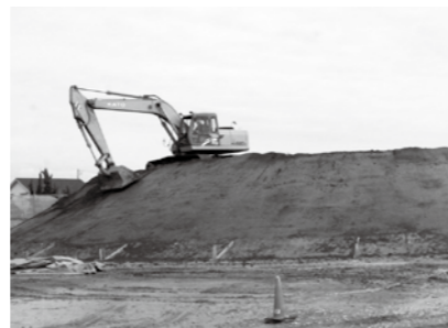
【築山公園建設状況 (H27.3.6)】 5メートルまでの盛土の施工が終わり、この後、5メートルの盛土を施工し、その後、植栽、遊具、駐車場等の施工が行われます。
