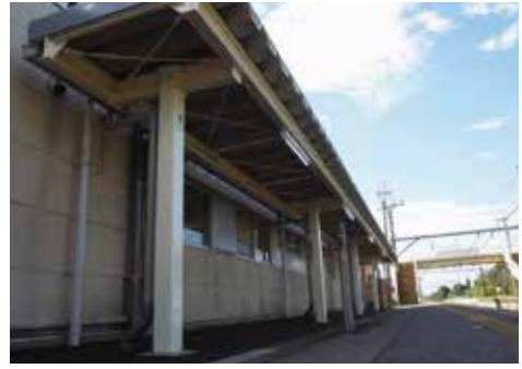
【新設された駅ホームの屋根】
