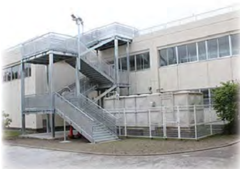
一松小学校：屋上津波避難階段
