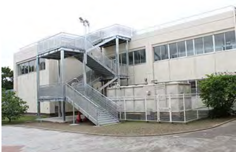
一松小学校：屋上津波避難階段
