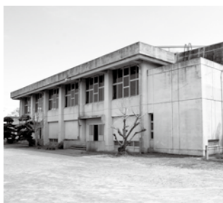
耐震補強が行われる高根小学校屋内運動場
