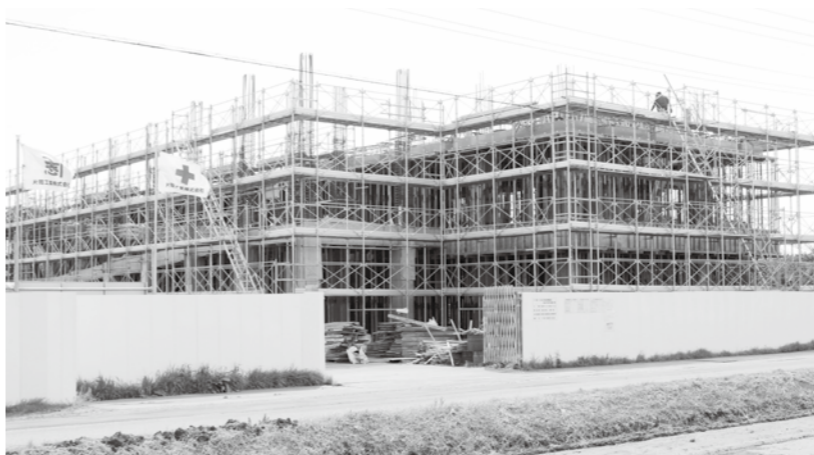
避難施設周辺の環境整備を進めます(驚地区集会所併用施設)
