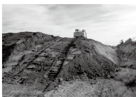
工事の進む城之内築山
