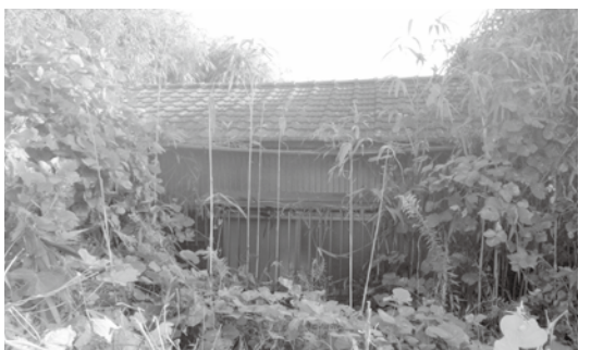
管理されず荒廃した家屋
