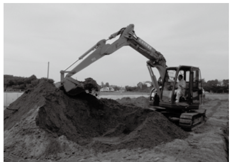
工事が始まった竜宮台築山
