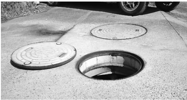
点検のため、ふたを開けた合併浄化槽
