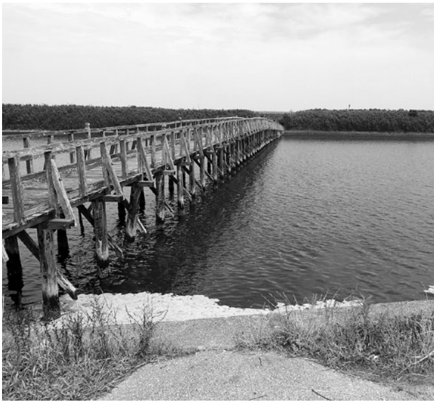
中瀬大橋周辺の堆積土砂を掘削します
