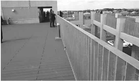
一松北部コミュニティセンターの屋上 (津波避難施設)
