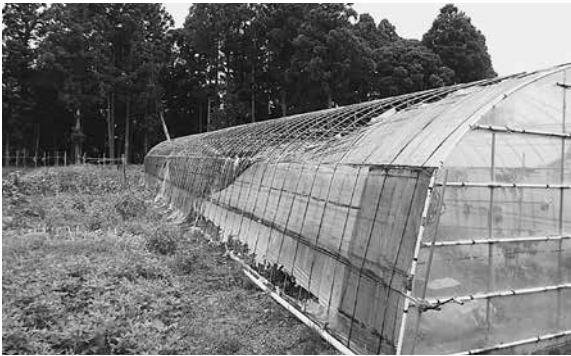
被害を受けた農業施設
