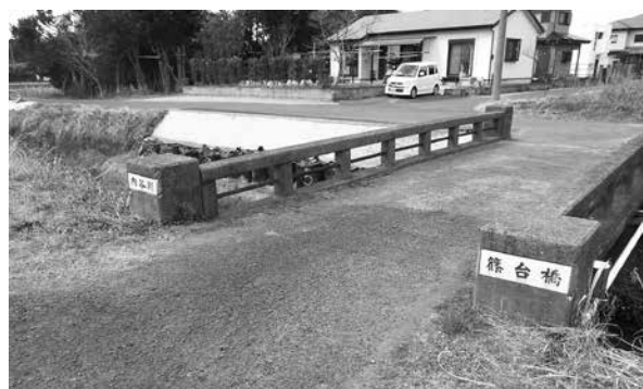
内谷川高根支線の復旧工事現場
