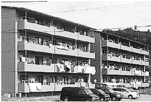
下条村村営住宅
