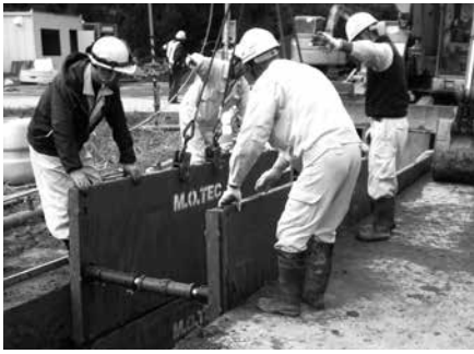
工事現場の様子
