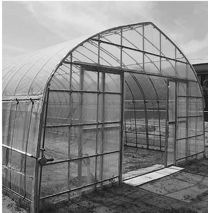
補助金を活用して建て直したハウス
