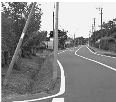
事故多発の現場
