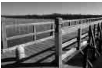
中瀬大橋 一松内水面にかかる木橋でその長さは102mあります。
