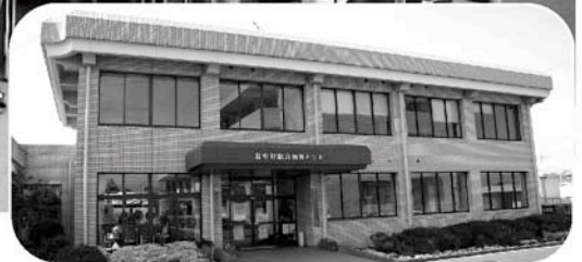
ボランティアセンターが設置される福祉センター
