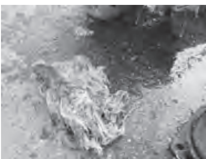
下水道管に詰まっていたモップ
