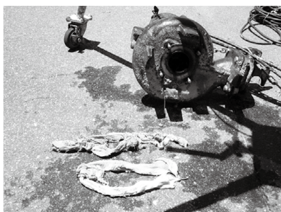
【下水道管に詰まっていたタオル】
