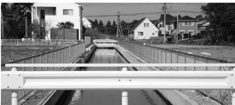
平成27年度の幹線工事完了箇所
