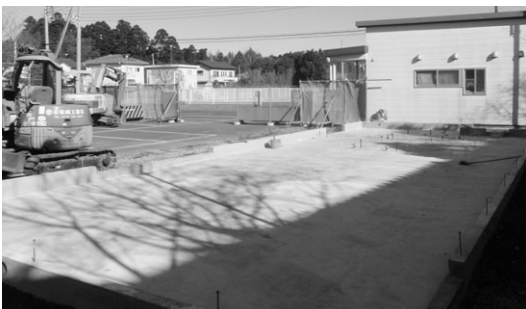
建設中の八積第2学童保育所
