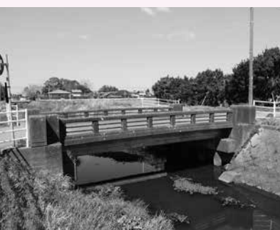
修繕予定の本郷橋
