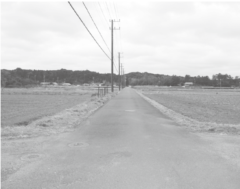
改修される村道（七井土地先）
