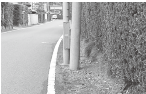
道路にはみ出す電柱
