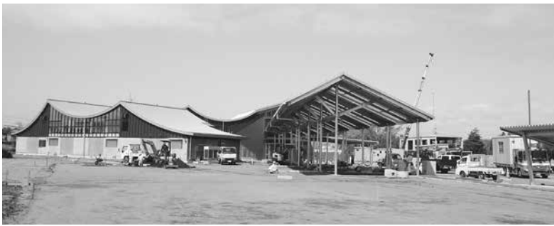
工事の進む長生村交流センター
